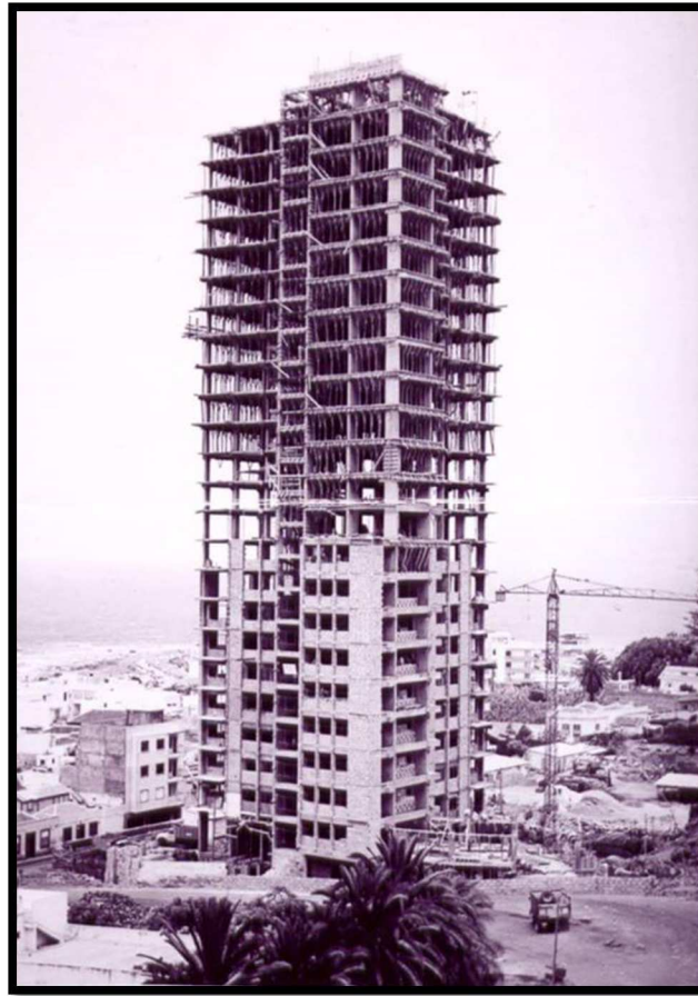
Hotel Belair en construcción 1962
