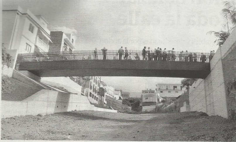
La nueva pasarela de La Vera, que sustituye al viejo puente de hierro y salva el barranco de San Felipe./ A.H.
