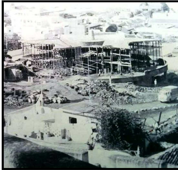
Construcción de la Gasolinera La Estrella
