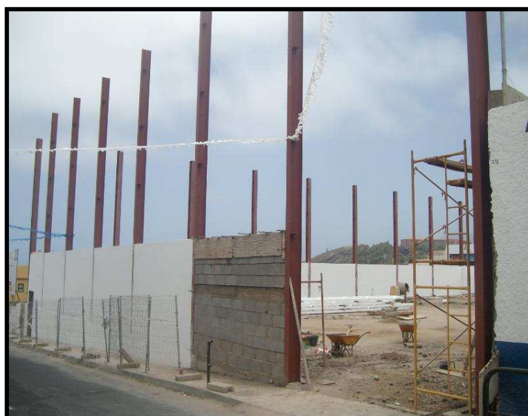
Aquí vemos los muros levantados y los pilares de hierro
