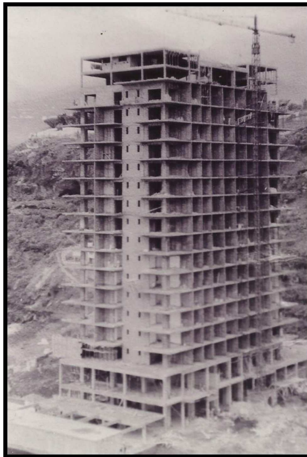
Hotel San Felipe en Construcción 1965
