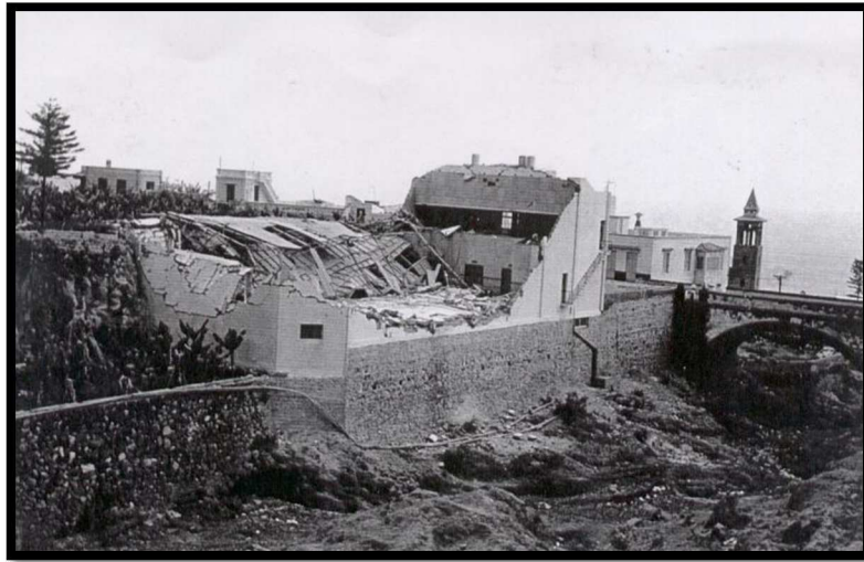
Imagen del estado en que quedo el mencionado Cine Vera
