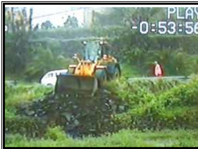
Descarga del camión con escombros para facilitar la bajada de la pala.
