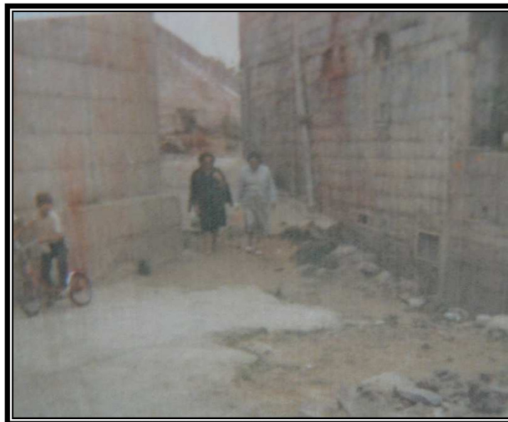
El camino en plena obra, con los muros de hormigón, baches en el camino, vecinas y un niño en bicicleta.
