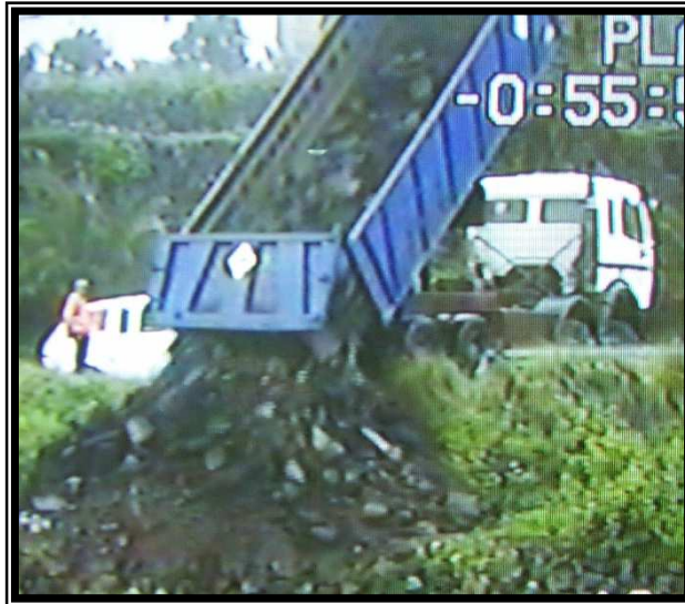
Descarga del camión con escombros para facilitar la bajada de la pala.
