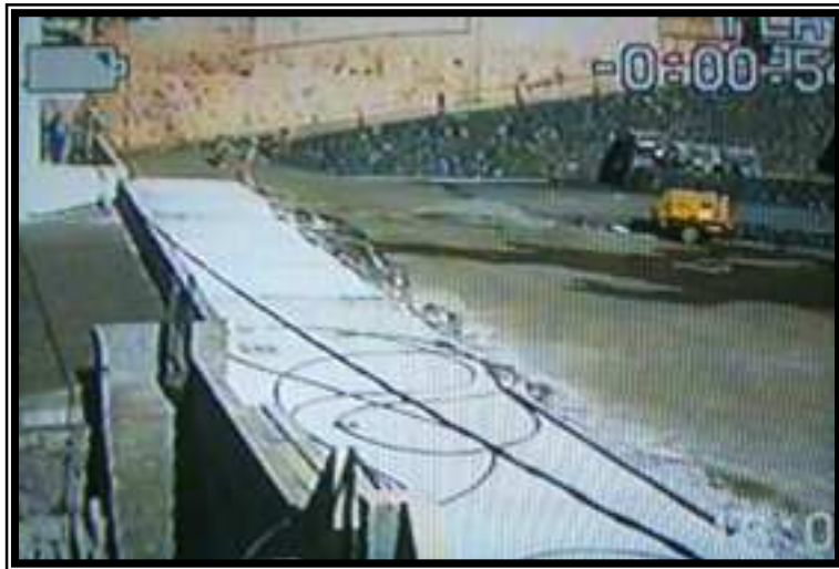
Preparando las aceras con una primera capa de tres cemento
