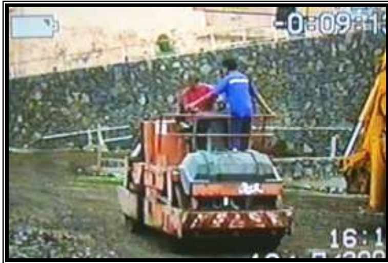
El futuro aparcamiento va cogiendo forma.
