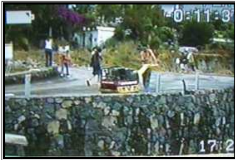
El pequeño cilindro remata los laterales y esquinas de la nueva vía.
